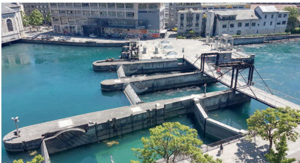
Fig. 17. Le barrage-écluse du Seujet inauguré en 1995 sert à réguler le niveau du lac, à moduler le débit du fleuve et à produire de l'énergie hydroélectrique.
