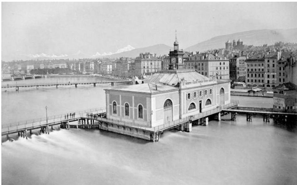
Fig. 11. Le pont de la Machine. Dès 1843, le bâtiment central abrita la machine hydraulique Cordier et ses annexes furent construites en 1863 et 1872. Auteur et date de la photographie inconnus.
