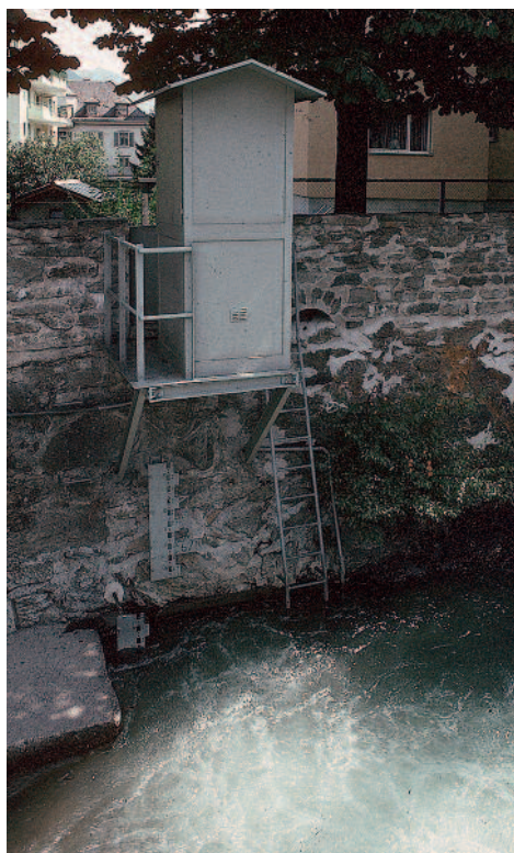
Fig. 3b. Mesure avec capteur «bulle à bulle» sur la Saltine (Brigue). (Photo: Beat Sigrist).
