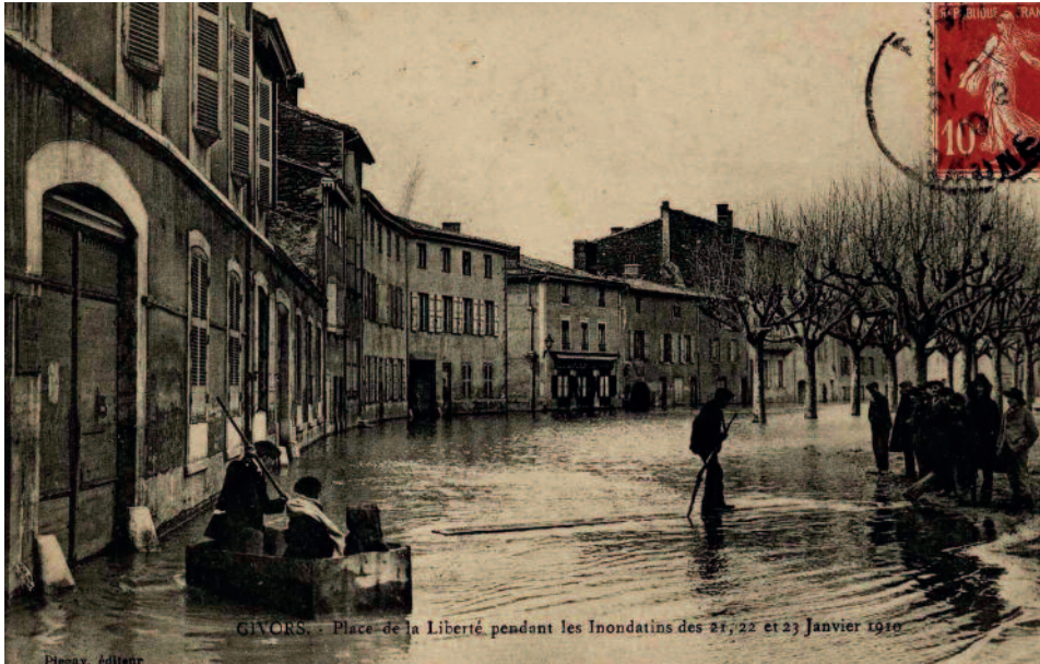
Fig. 9. Place de la Liberté pendant les inondations des 21, 22 et 23 janvier 1910, Givors.
