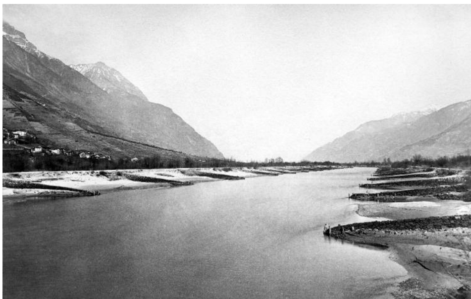
Fig. 4. Ouvrages emblématiques de la Première Correction du Rhône, les épis en maçonnerie sont disposés perpendiculairement au fleuve sur chaque rive, comme ceux qui ont été photographiés ici, dans la région de Branson à Fully, dans les années 1900.
