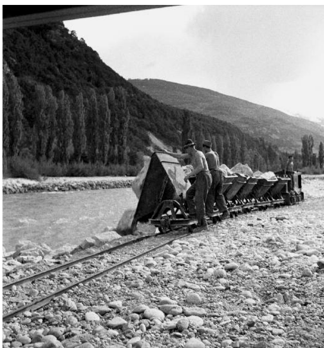
Fig. 5. Des ouvriers s'affairent aux travaux d'enrochement des digues du Rhône dans la région de Granges, en 1946.
