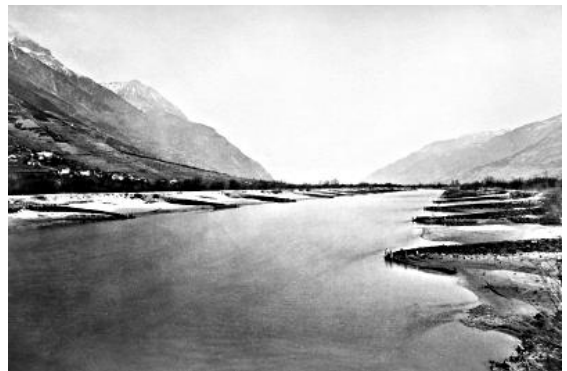
Ouvrages emblématiques de la 1ère Correction du Rhône : les épis en maçonnerie sont disposés perpendiculairement au fleuve sur chaque rive, ici dans la région de Branson à Fully dans les années 1900.
