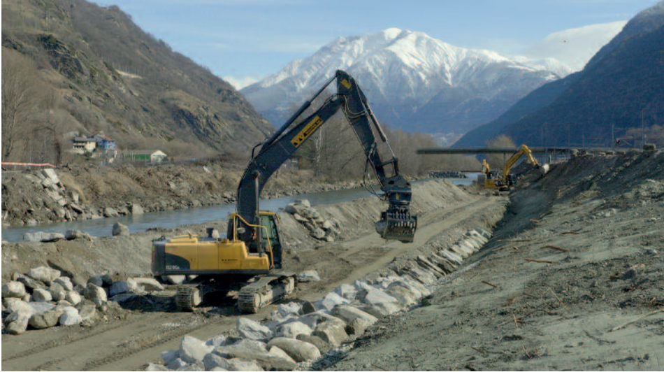
Fig. 2. Chantier de la Troisième Correction du Rhône à Lalden, Dans le lit du Rhône , GoldenEggProduction.
